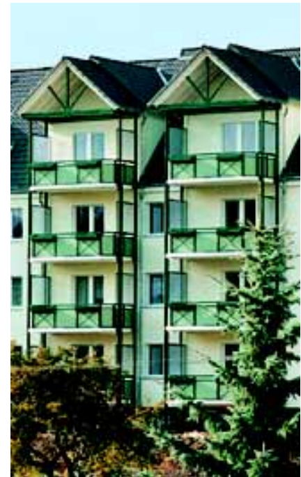
4 Stützen an allen Balkonecken. Baukörperanschluss mit Gleitanker.
