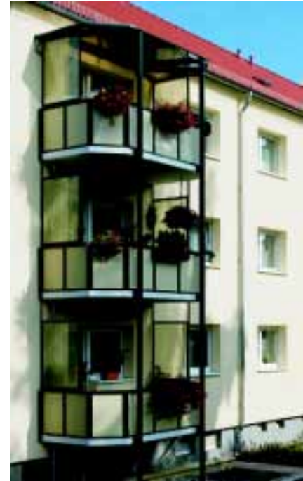
2 Stützen an der Frontseite des Balkons. Anbindung an die Fassade durch starre Wandanker.
