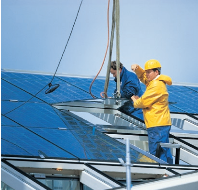
Glaseinbau im Lichtdachbereich Glazing in the skylight area
